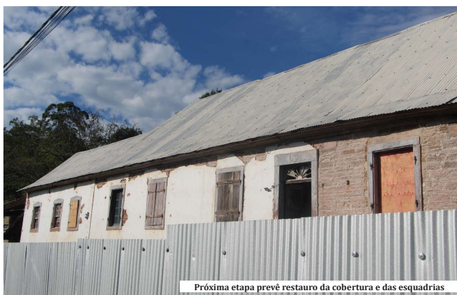
Próxima etapa prevê restauro da cobertura e das esquadrias
